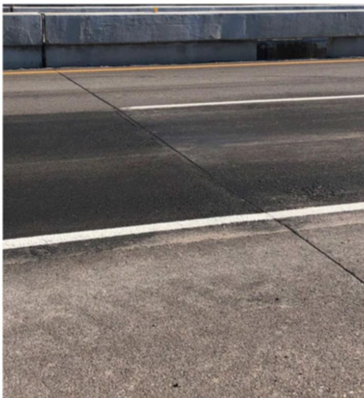
**Figure 3-5: Example of a hot pour joint seal.**
