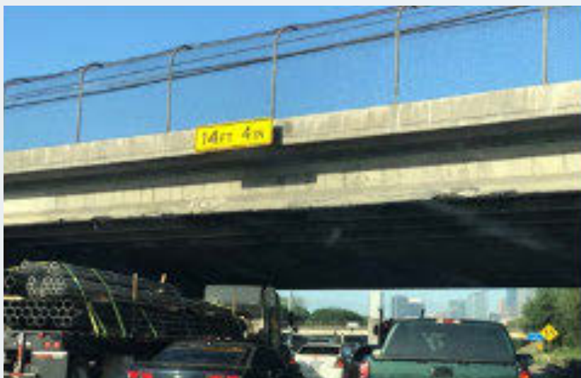
Se levantarán puentes para cumplir las normas nacionales de altura.
