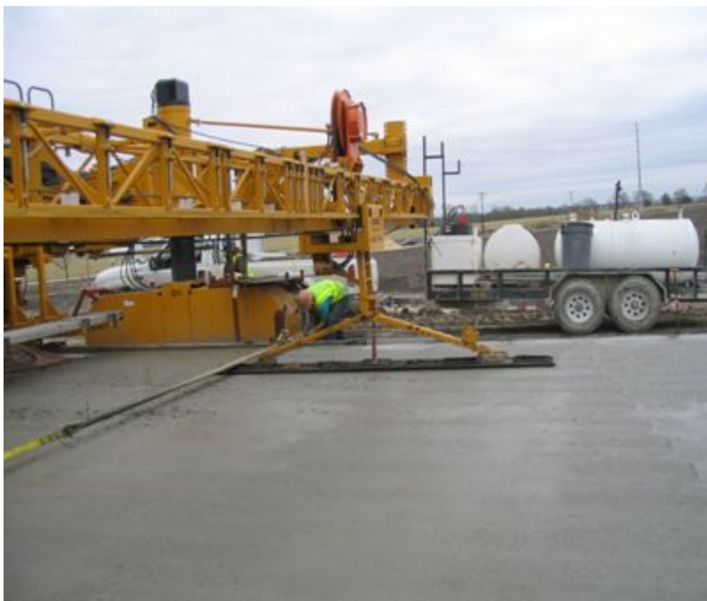
Figure 9-51. Longitudinal float.
